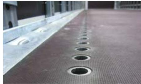
Das enge Raster der Lochschielen erlaubt maximale Flexibilität bei der Positionierung der Stützen.
